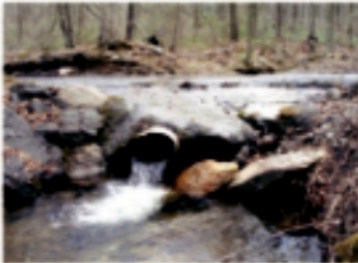
إلقاء مياه الصرف الصحي في الترع شكل (١٣)
